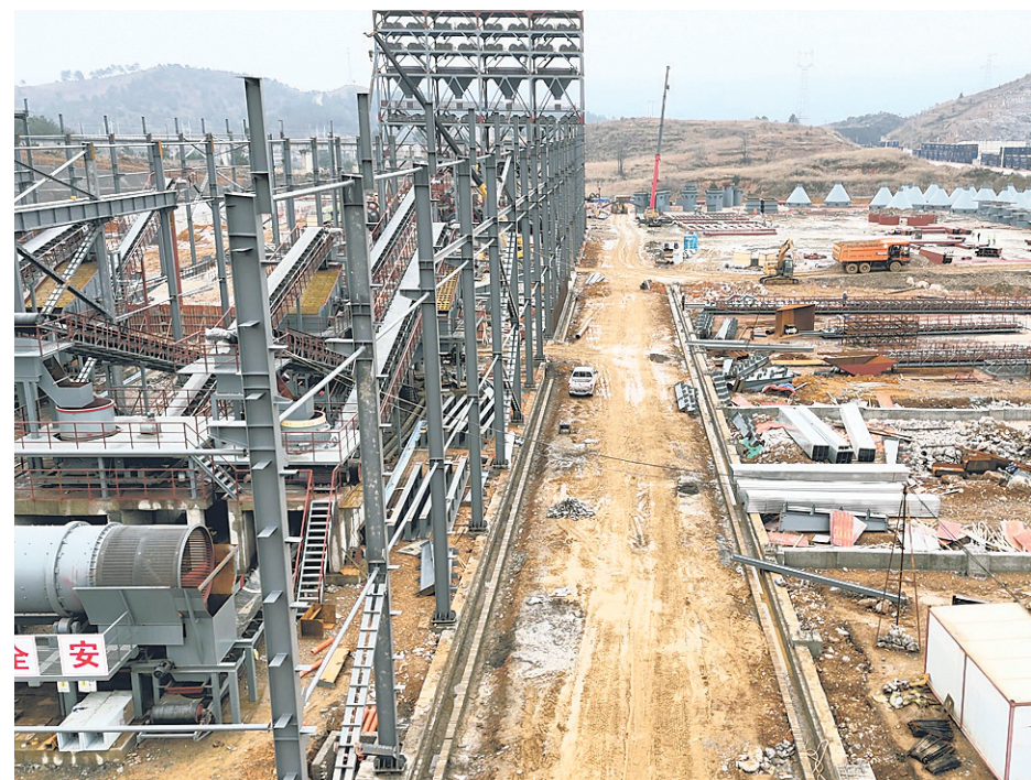
项目建设现场
