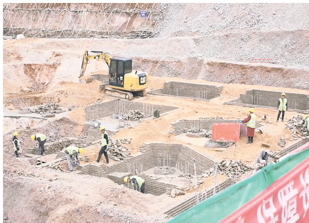
工人抓紧时间施工
