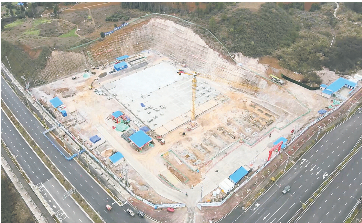
项目建设现场
