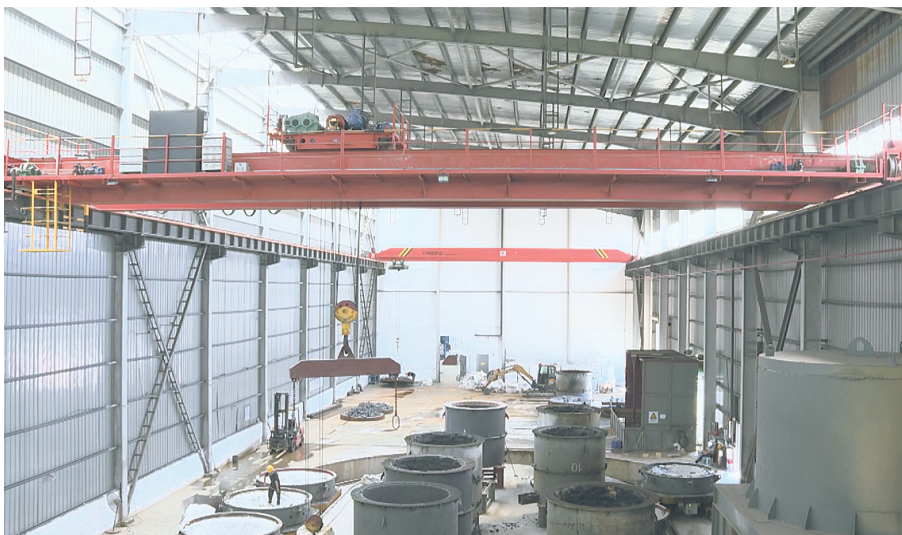
福泉鸾航新材料有限公司生产车间一角
