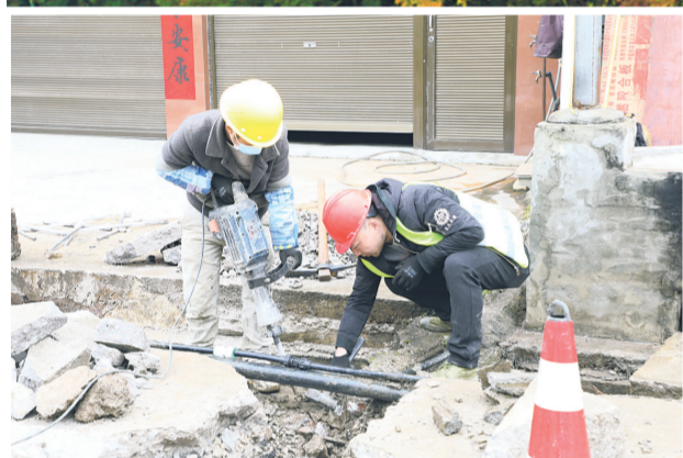
建设中的排污管网
