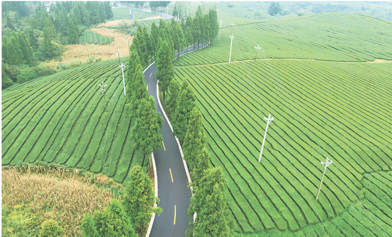
路面处治后的S206线
