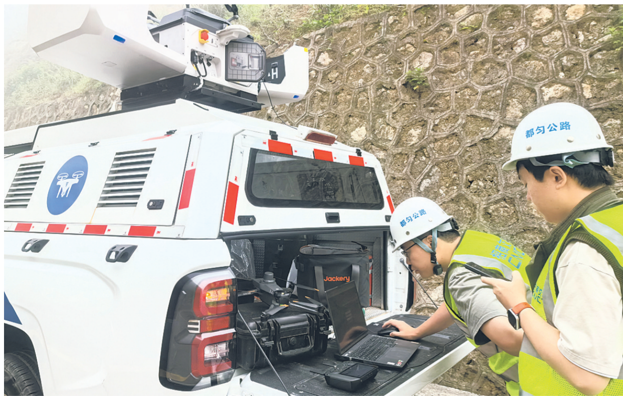
工作人员运用无人机边坡巡检技术排查隐患 黄娅 摄
